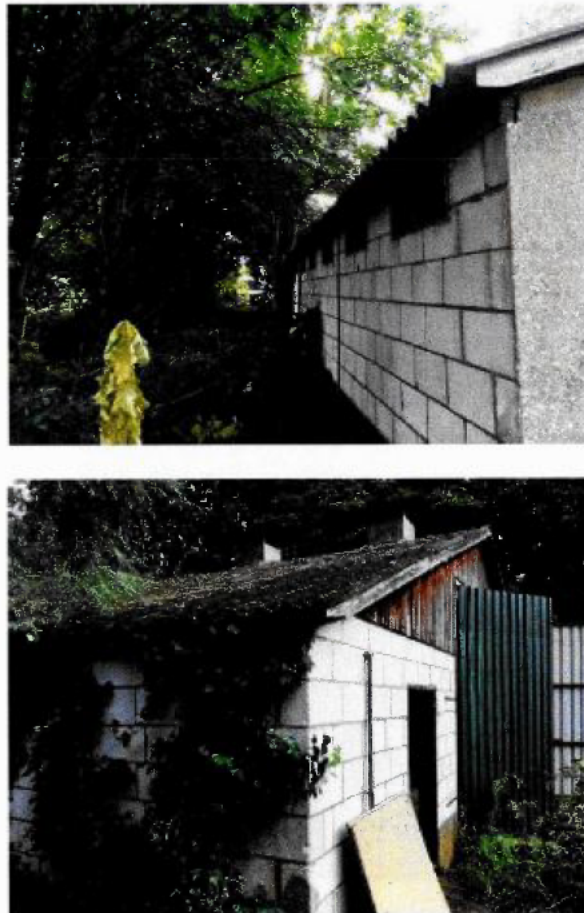
Figuur 3. Dragonderweg 8 schuur noord met langgevel noord (boven) en kopgevel oost (onder)
