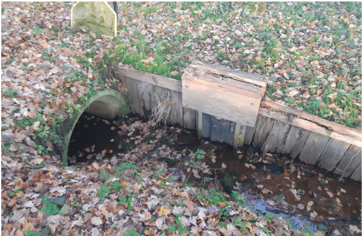
Figuur B4 Locatie 3 en 4: verleggen afwatering naar ander kant Bergweg.
