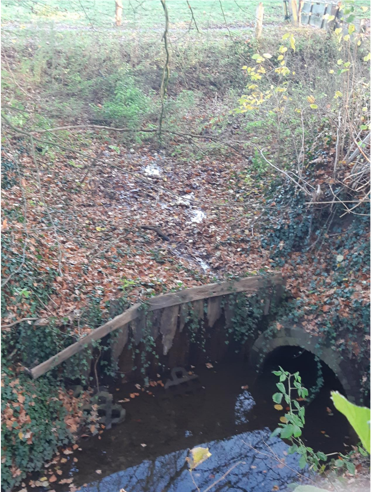
Figuur B7 Locatie 6: damwand aan Oosteriksweg verwijderen.
