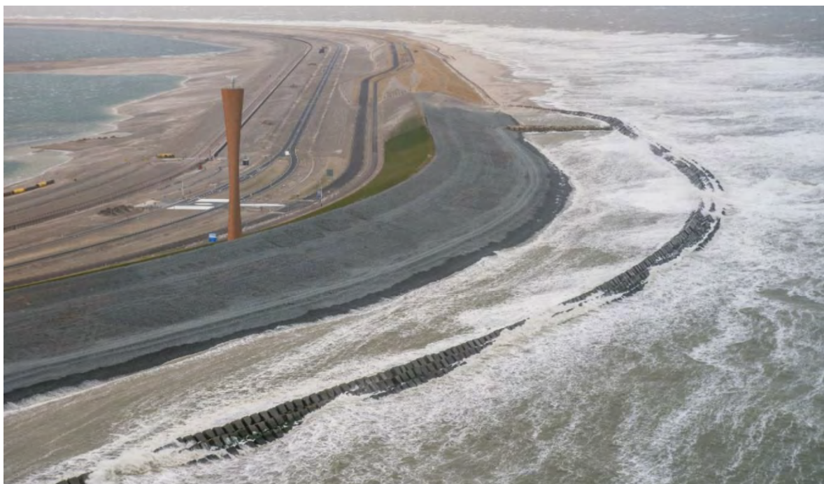
Figuur 4: harde zeewering met blokkendam en radartoren en de overgang naar de zachte zeewering
