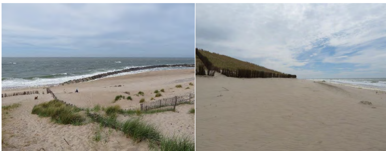
Figuur 3-8: Overgangszone bij het einde van de blokkendam (links) en direct ten zuiden daarvan, nabij locatie windturbine ZZ-01. In september 2019 was PUMA bezig met zandsuppletie en daarmee verbreding van het duin. De situatie op de foto is van 22 mei 2020 vlak voor hoogwater.
