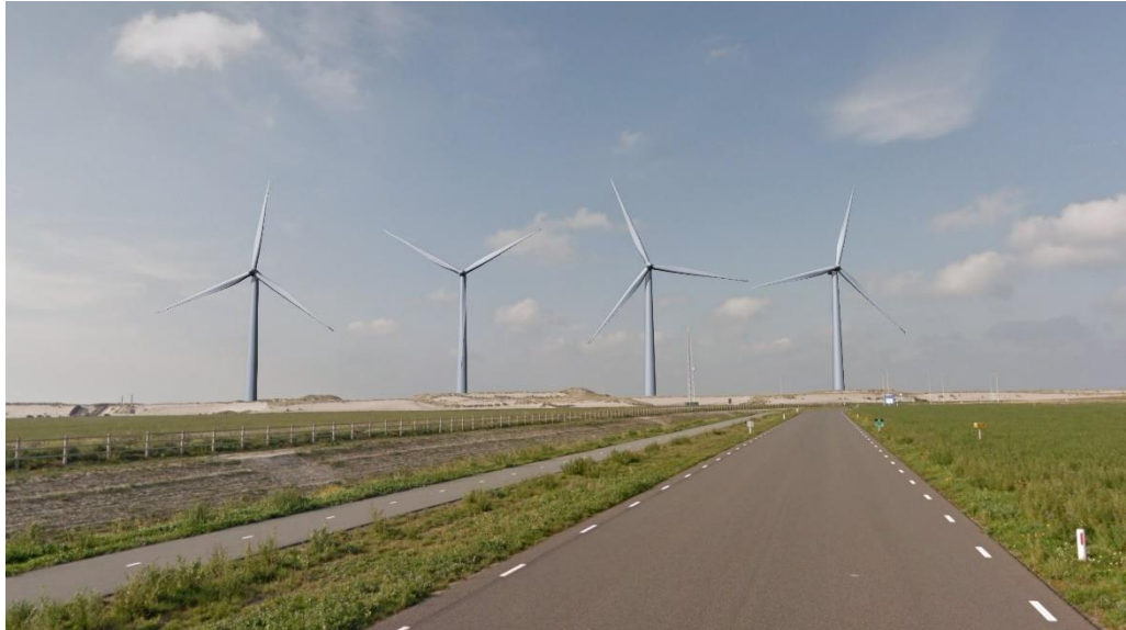
Figuur 4.13 Indicatie verhoudingen windturbines grote klasse (1e links (mast klein/ rotor groot) ;2e links (mast klein/ rotor klein); 1e rechts (mast groot/ rotor groot); 2e rechts (mast groot/ rotor klein))
