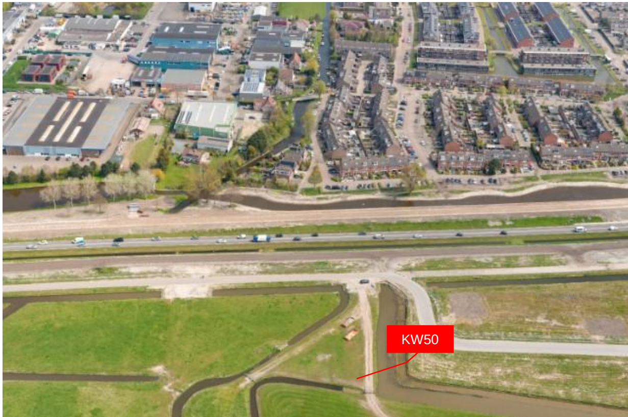
Figuur 6: Luchtfoto t.p.v. perceelaansluiting KW50 (genomen medio mei 2021)
