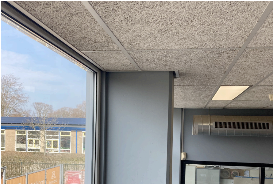
Voorgevel | gezien naar beton kolom
