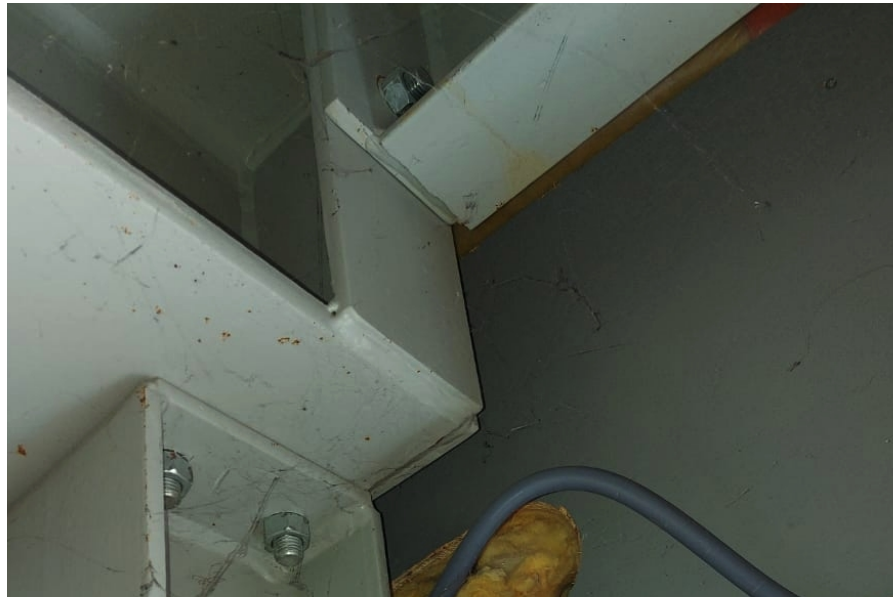
Achtergevel | gevelbalk met kolom rechts (van binnenuit gezien)
