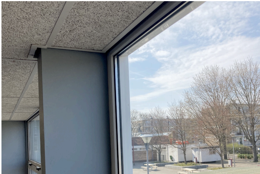
Voorgevel | gezien naar omtimmerde kolom
