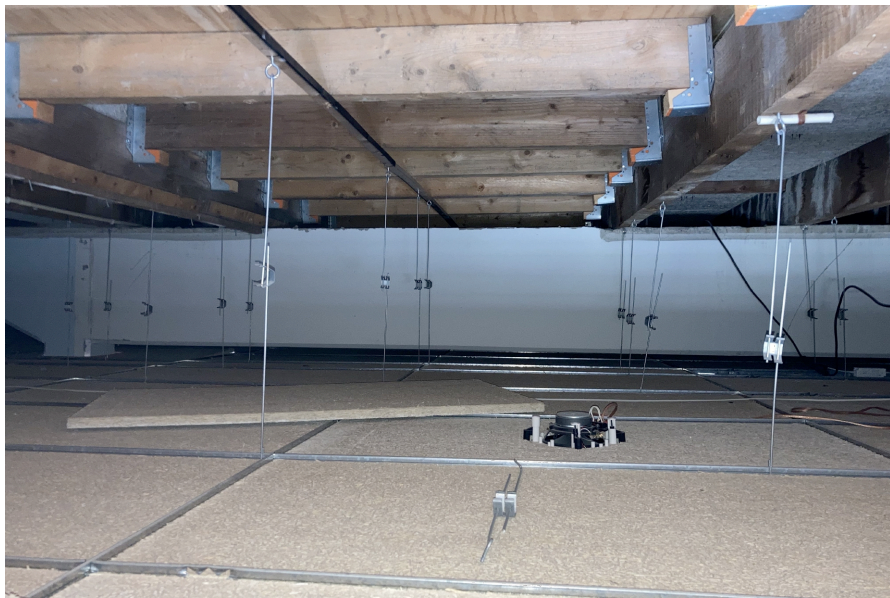
Voorgevel | ruimte bovenplafond gezien naar voorgevel
