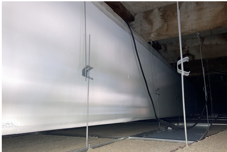
Voorgevel | balk die belemmering vormt
