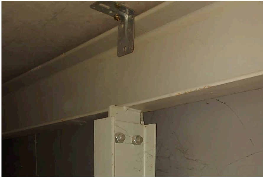
Achtergevel | gevelbalk met kolom links (van binnenuit gezien)
