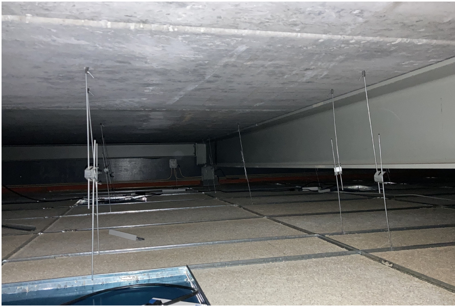
Achtergevel | ruimte boven plafond gezien naar achtergevel
