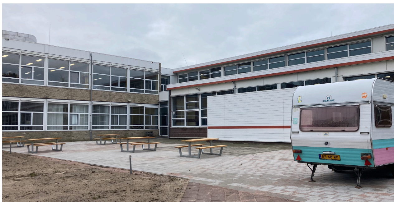
Samengestelde foto achtergevel | positie nieuwe sectiedeur
