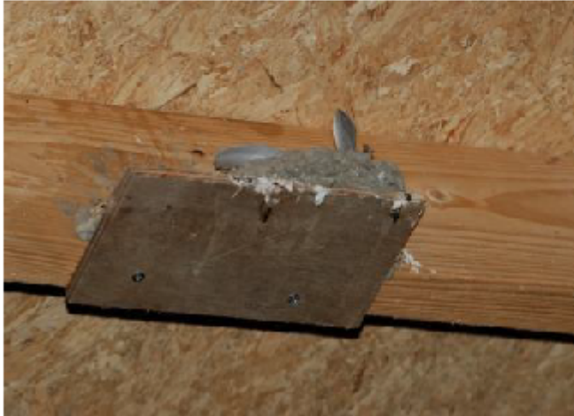
Figuur B1 Voorbeeld van een nestplank voor boerenzwaluw. De nestplank wordt op eenvoudige wijze gemonteerd aan de onderzijde van een houten draagbalk. Bron: O. de Vries.
