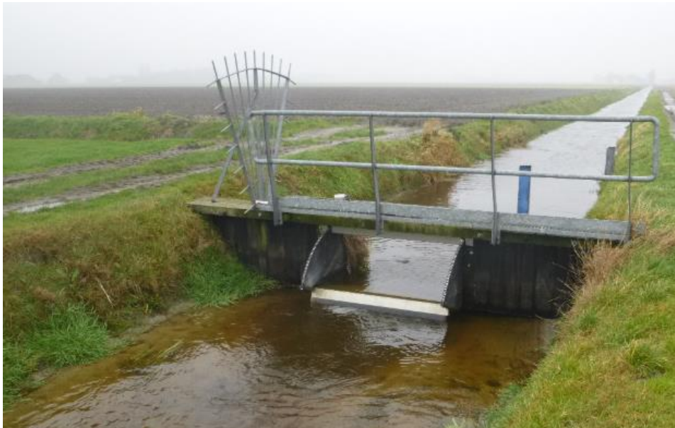
Figuur 10: Indicatieve opstelling handbediende klepstuw.
