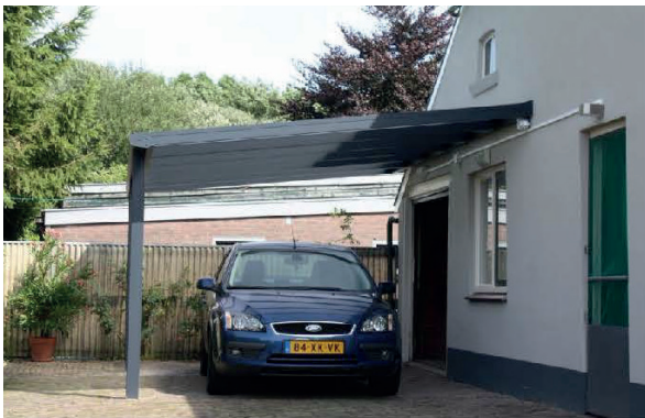
Aangebouwde carport licht hellend dak
