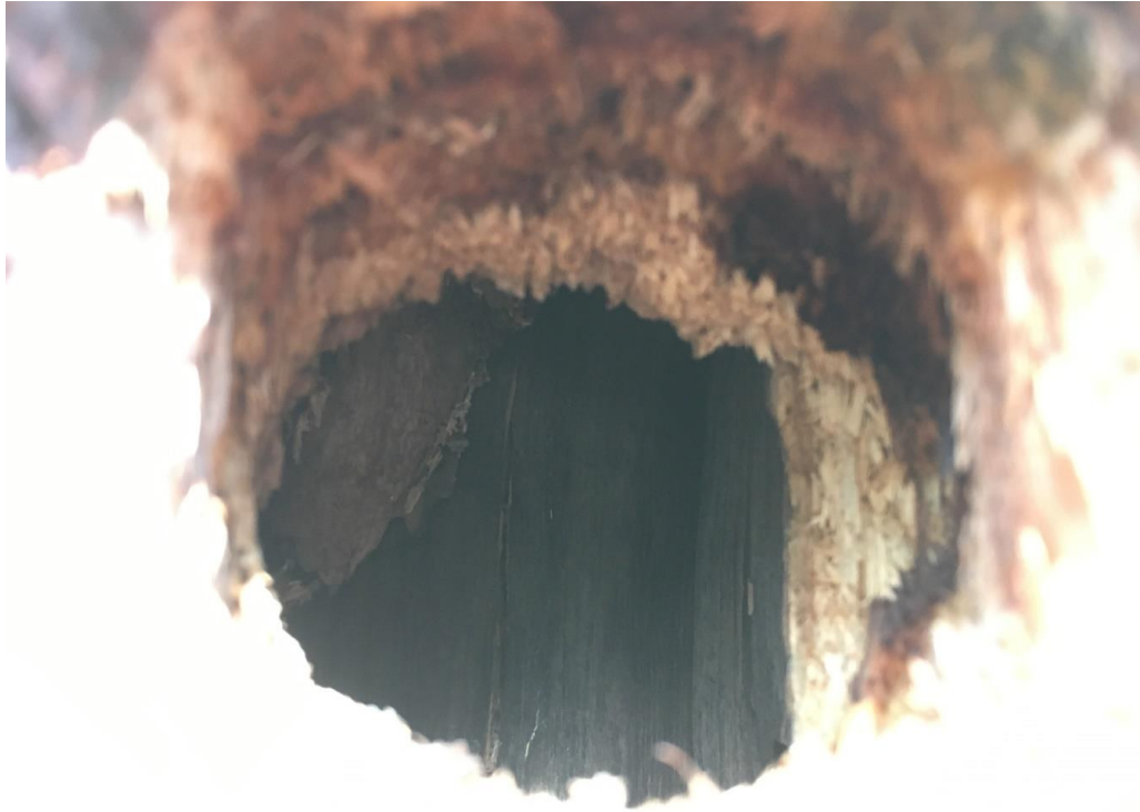
Figuur 4 Naar boven ingerotte holte ontstaan uit een spechtenhol. Doordat het hol naar boven is ingerot kunnen vleermuizen hier een geschikte verblijfplaats vinden.
