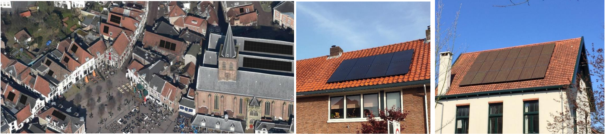
Afbeeldingen links: toepassing van (zwarte) zonnepanelen op niet zichtbare dakdelen
