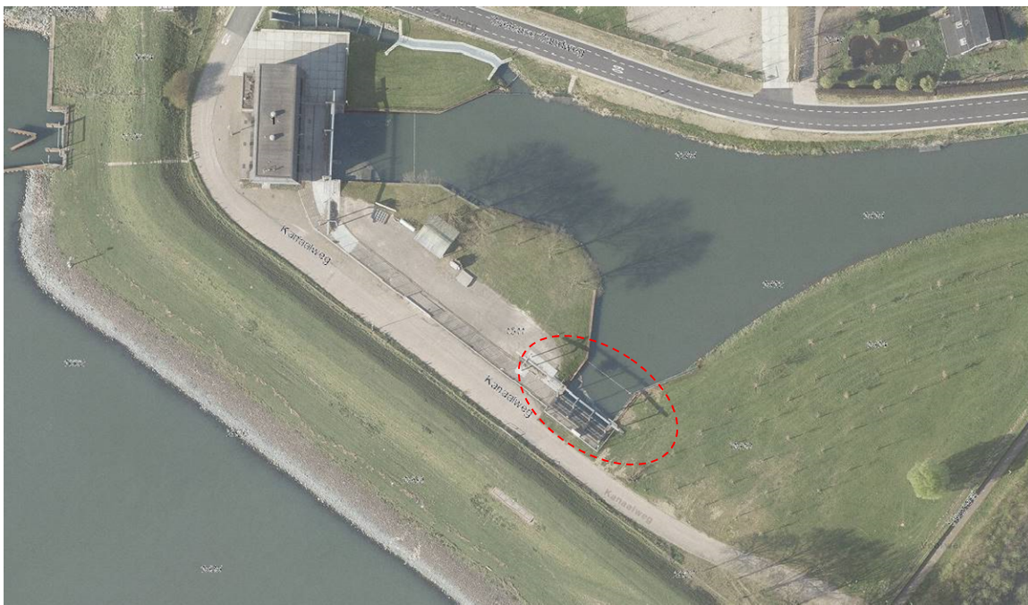
Figuur 1 - Luchtfoto situatie noordzijde Amsterdam-Rijnkanaal met te verwijderen schuiven
