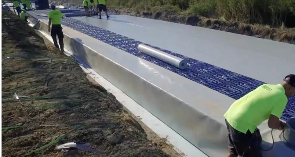
Figuur 2 Infiltratie-laag bestaande uit aan elkaar gekoppelde kratten ingepakt in geo-textiel.
