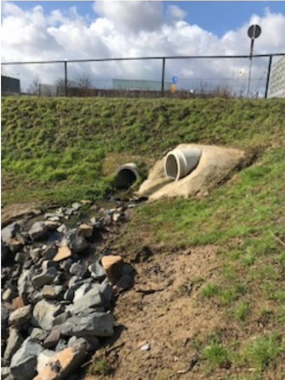
Overkluizing Reijmersbekervloedgraaf 6.037H.0003 (links) bestaand lozingspunt ID: 128193 (rechts)
