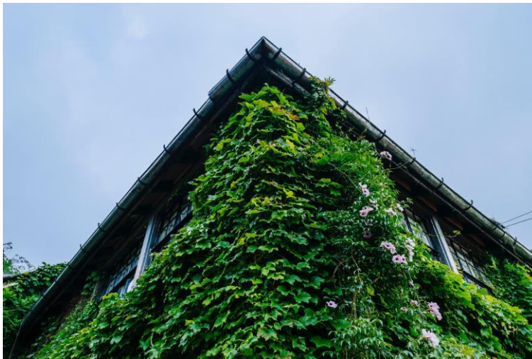
Figuur III 18 Groene gevel (foto: Subhrajyoti Saha)
