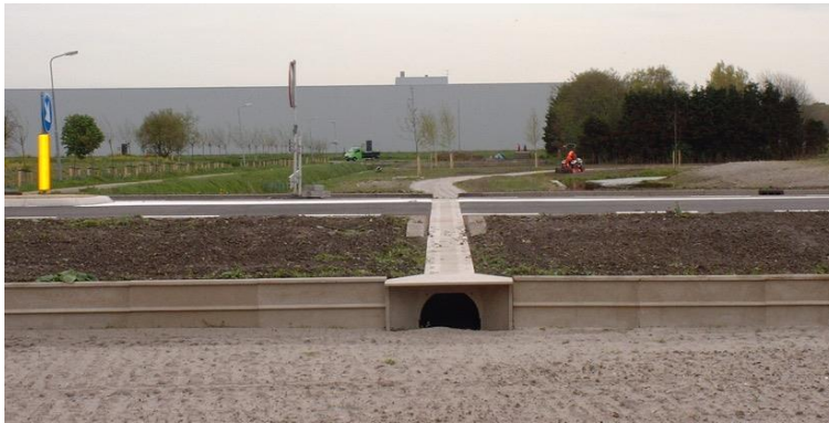
Figuur III 14 Halfopen amfibieëntunnel.
