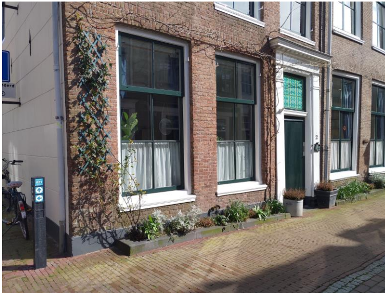
Figuur III 19 Geveltuin binnenstad Culemborg
