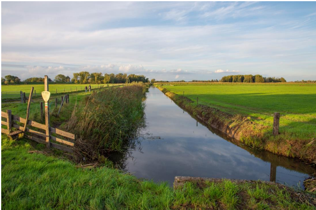
Figuur 3.6 Natuurvriendelijke oever (links) in de verbindingszone Diefdijk-Lek versus een reguliere oever (rechts).
