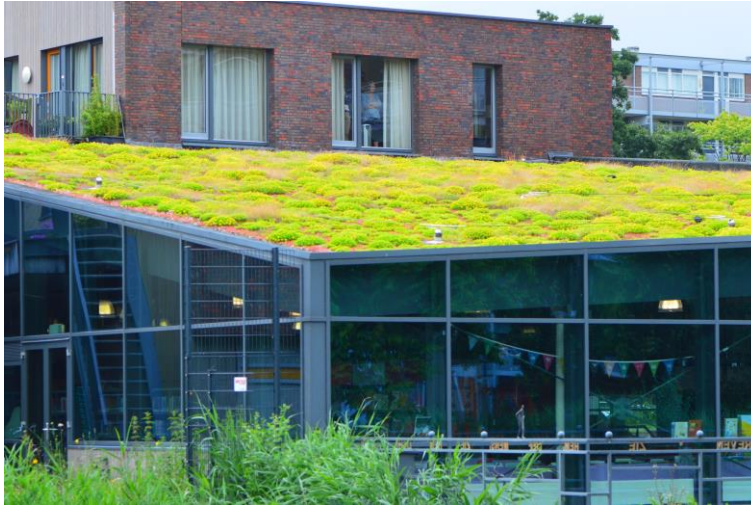
Figuur III 17 Groen dak
