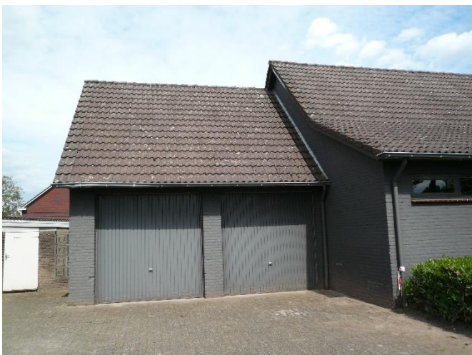
foto's bestaande situatie
