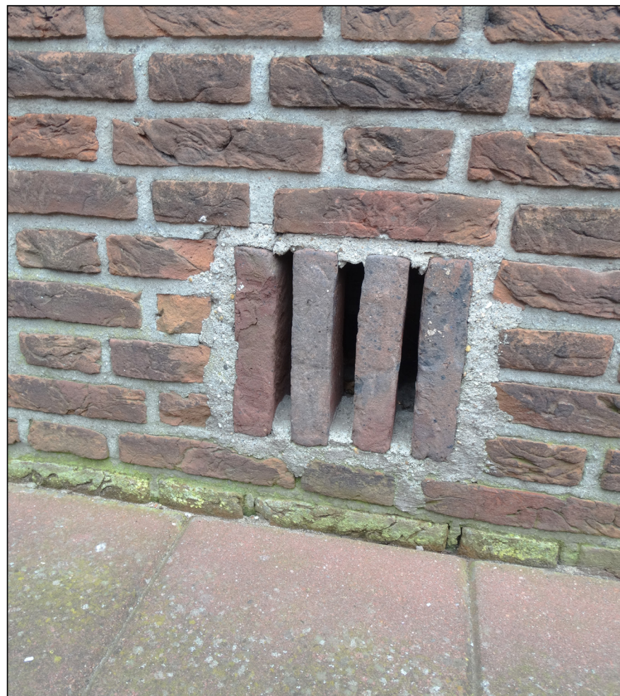
Figuur: de kerk heeft ook een kruipruimte die toegankelijk is voor vleermuizen via deze grote open stootvoegen. Hier vinden, aan de binnenzijde van de kerk, geen werkzaamheden plaats.
