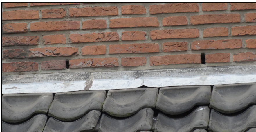
Figuur: de oost- en westzijde van de kerk hebben open stootvoegen waardoor dwergvleermuizen in de spouw kunnen kruipen. Er vinden geen werkzaamheden aan de spouw plaats.
