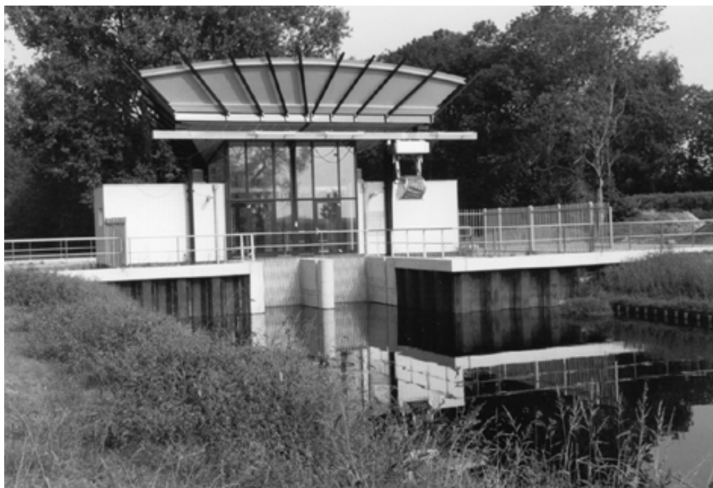
Gemaal bij Skoatterwâld
