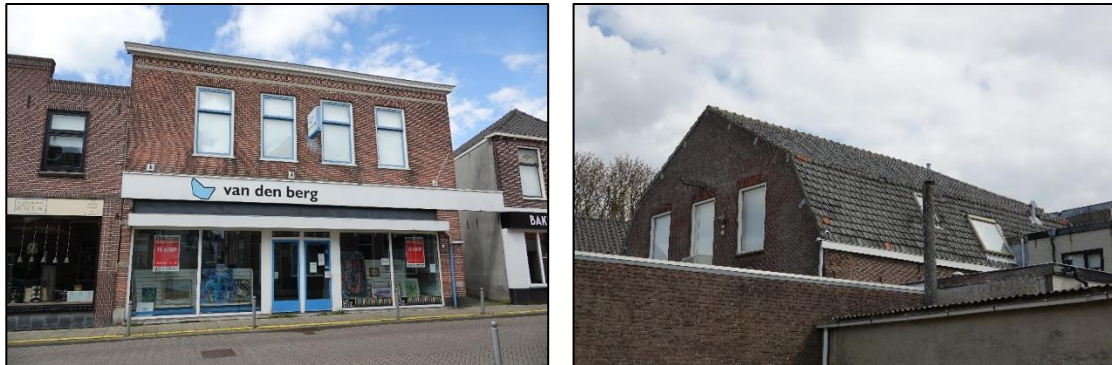
Figuur 2: Opstal aan de Achterweg 12 van twee verdiepingen en dakpannen dak.
