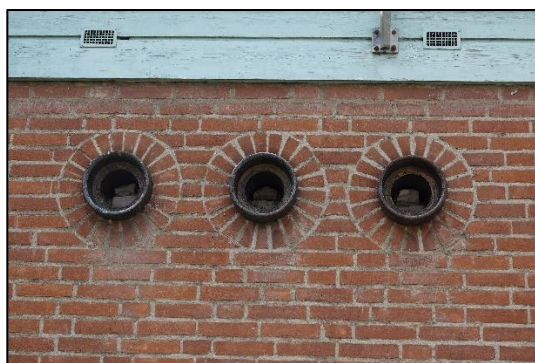
Figuur 8: Buizen welke uit de gevel steken aan de Kerkstraat en gevuld zijn met diverse materialen.
