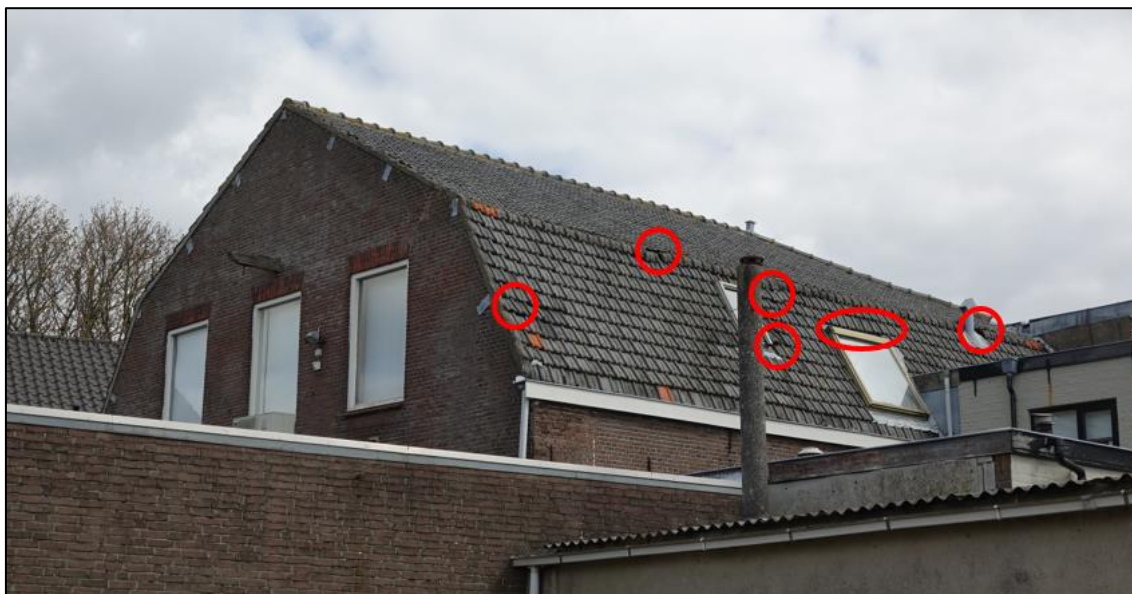
Figuur 12: Indicatie van een aantal van de openingen in het dakpannen dak.
