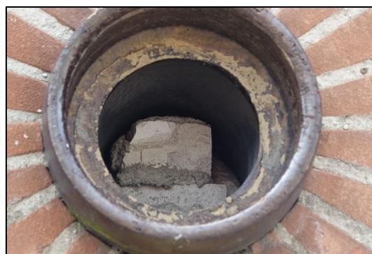
Figuur 8: Buizen welke uit de gevel steken aan de Kerkstraat en gevuld zijn met diverse materialen.
