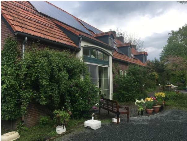
Foto 1 Achterzijde woning (linkerzijde)
