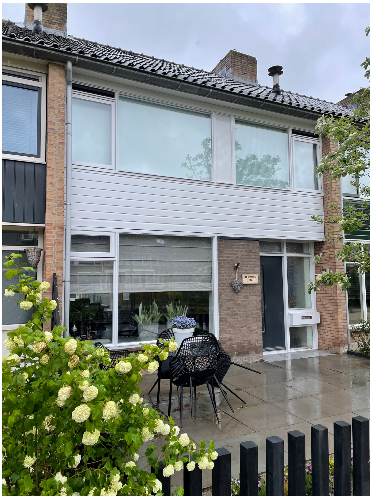
Bestaande voorgevel Mauritsplantsoen 25
