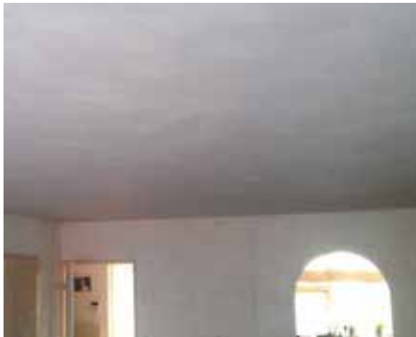
Voorbeeld van schuurwerk
