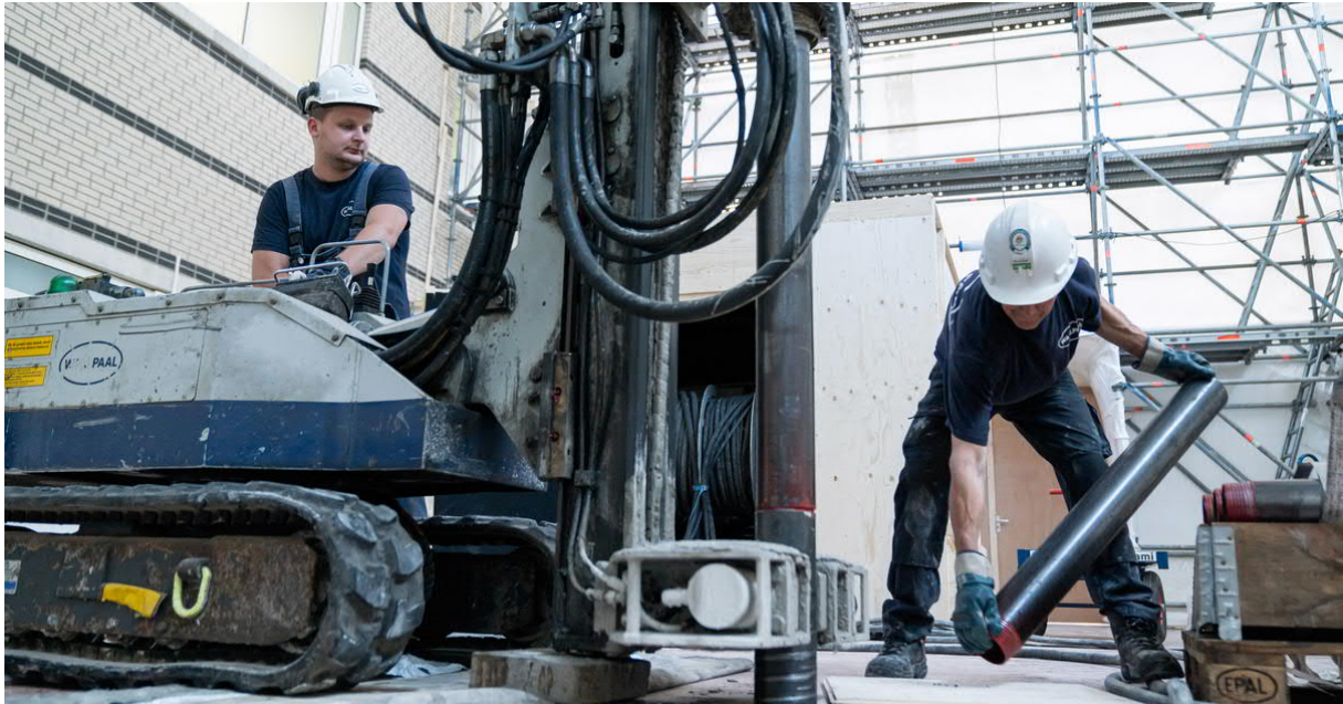
Figuur 9 Voorbeeld plaatsen nieuwe segmenten
