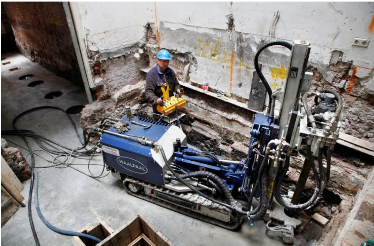
Figuur 8 Schroefstelling (funderingsmachine)
