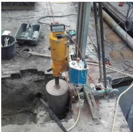
Figuur 7 Voorbeeld boorstatief en boorkernen
