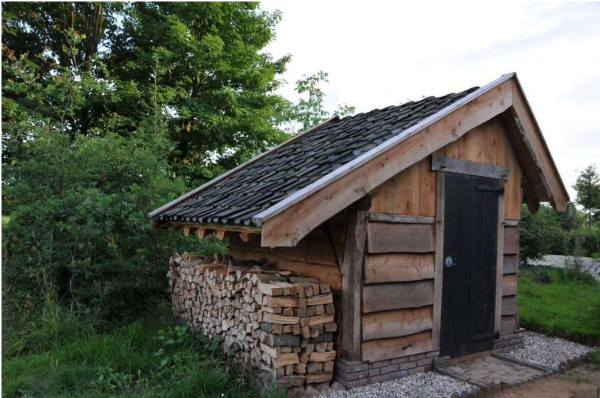
Afb. 2. Voorbeeld potdekselwerk
