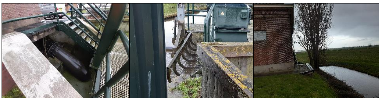
Afbeelding 3: Inlaat met persleiding en betonnen wanden (links), kraan en houten kroosbak (midden) en cotoneaster en twee bomen langs oever (rechts).
