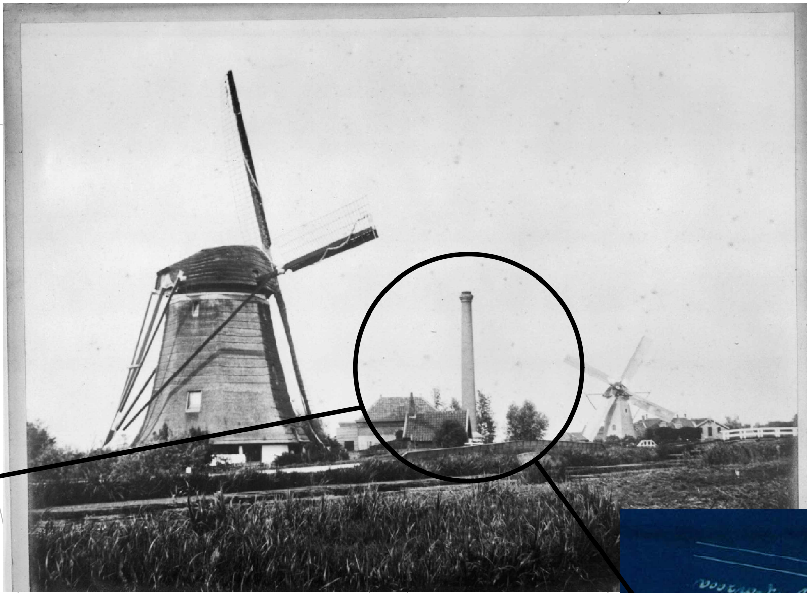
locatie voormalige schoorsteen stoomgemaal 1873
