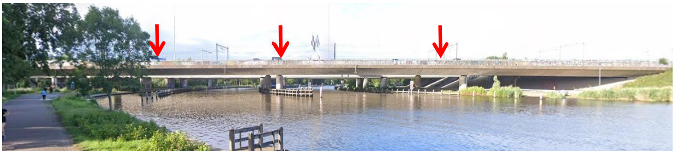
Figuur 1.1: Overzicht Rozenoordbrug Zuid A10 over de Amstel
