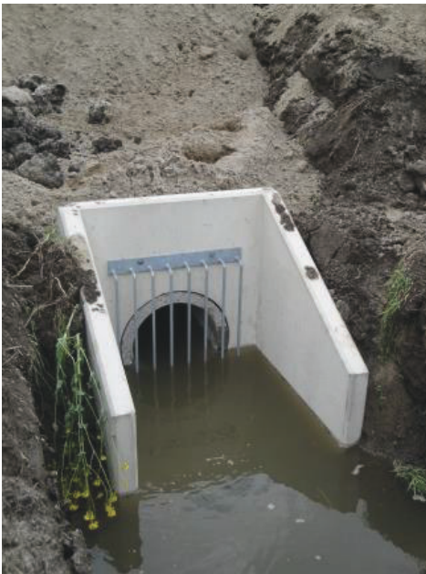
Figuur 4.5 | voorbeeld / principe van het uitlaatwerk
