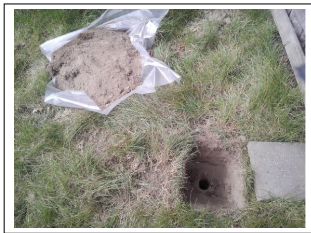
Foto: Inspectiegat A11
