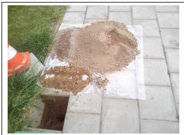
Foto: Inspectiegat B10
