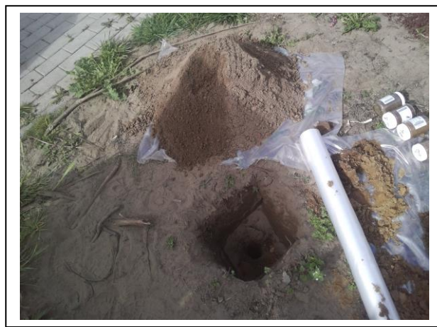
Foto: Inspectiegat A07
