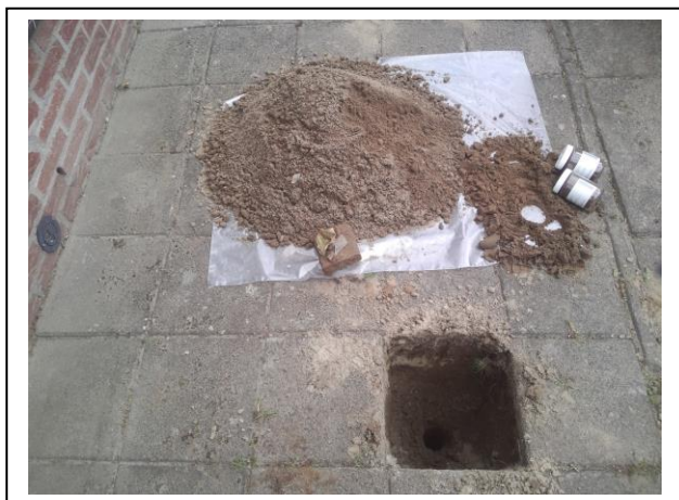
Foto: Inspectiegat A04
