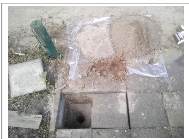
Foto: Inspectiegat A01
