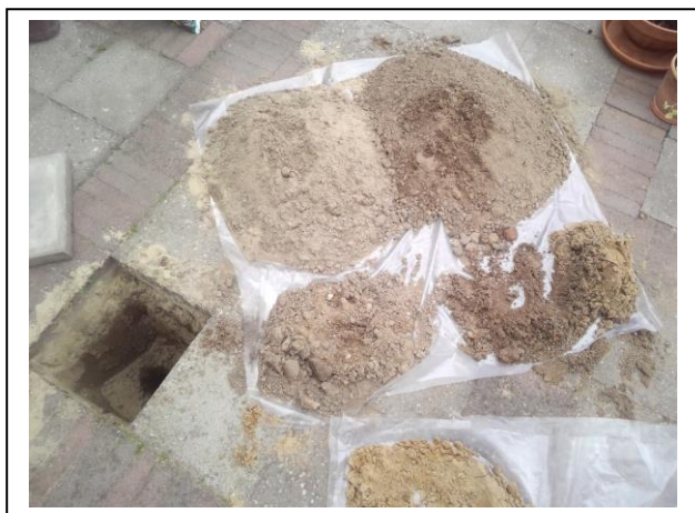
Foto: Inspectiegat B12
