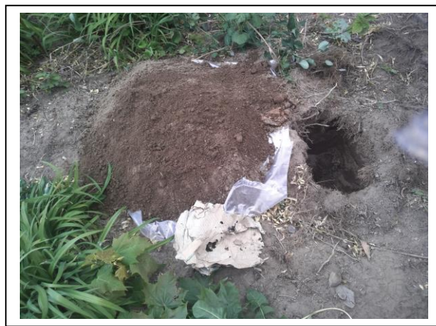
Foto: Inspectiegat A05
