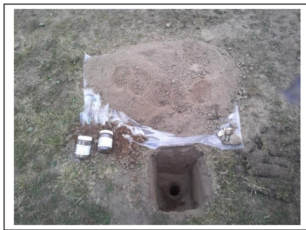
Foto: Inspectiegat A13
