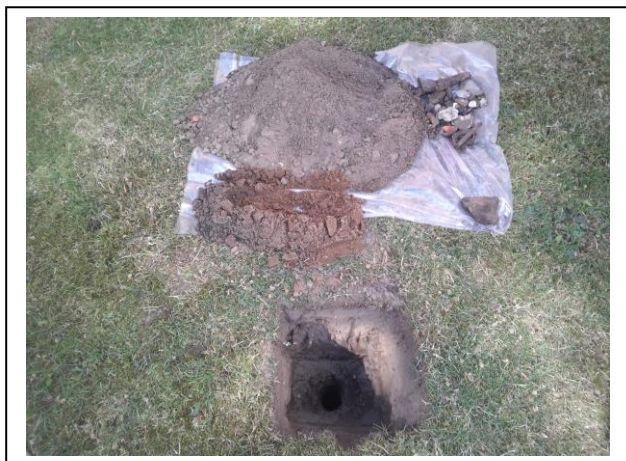
Foto: Inspectiegat B08
