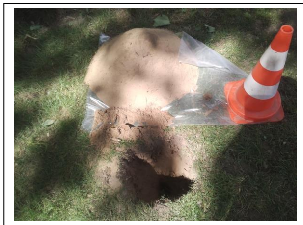
Foto: Inspectiegat B02
