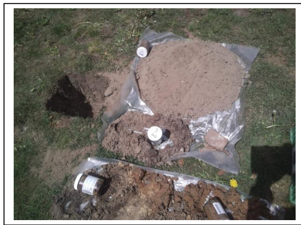
Foto: Inspectiegat B09
