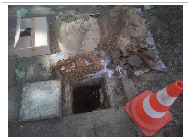
Foto: Inspectiegat B01
