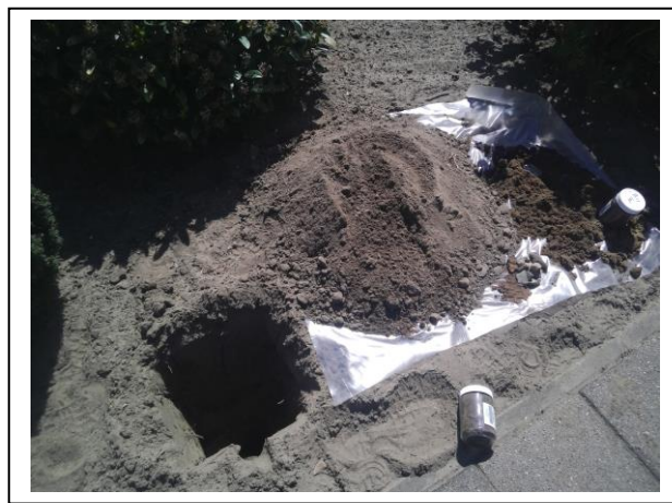
Foto: Inspectiegat B11
