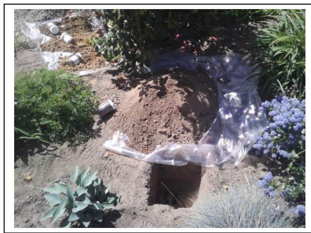
Foto: Inspectiegat B13
