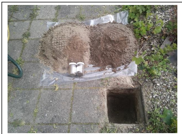
Foto: Inspectiegat A08
