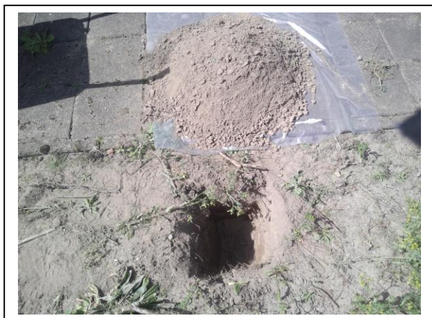
Foto: Inspectiegat A10
