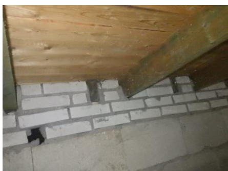
voorbeeld kruipruimte / Foto 7
