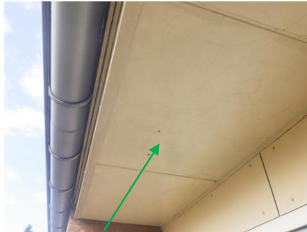
voorbeeld niet asbestverdachte gevelbekleding / Foto 12
