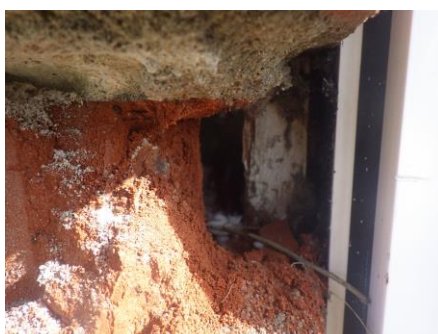
voorbeeld onderzoek spouwmuur / Foto 8
