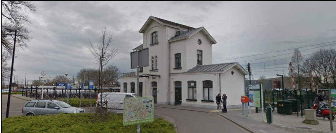
Foto voormalige stationsgebouw (en huidige stationsomgeving ten noorden van het station)
