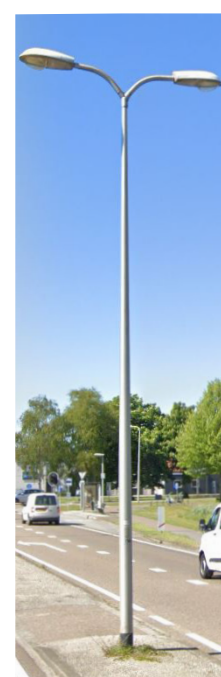
bestaande lichtmasten in Stationsstraat 6m
