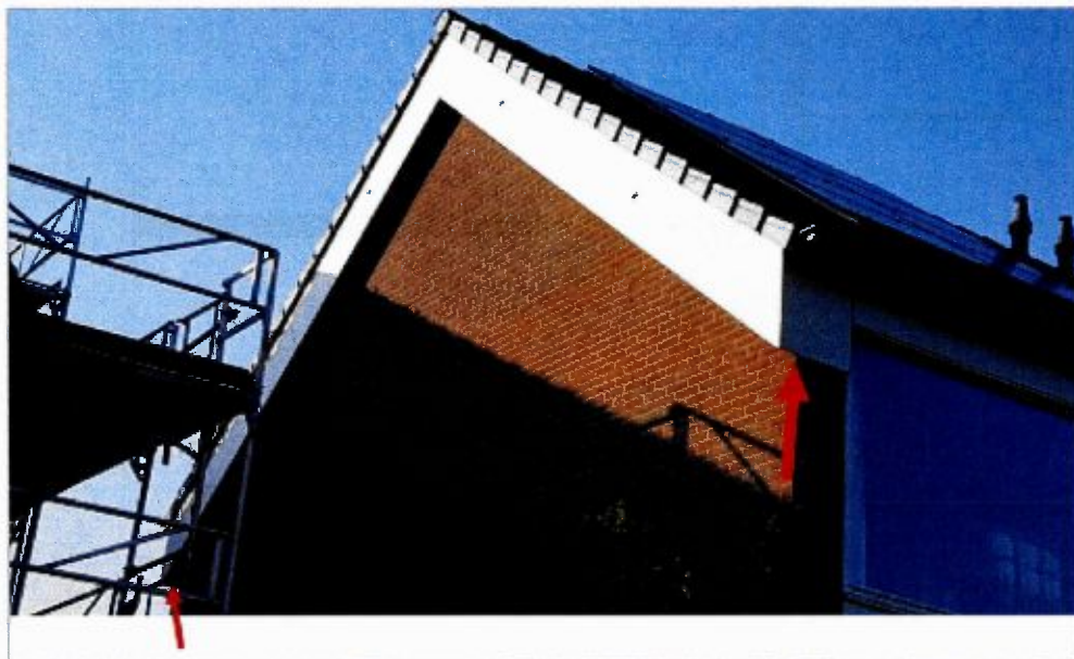
Figuur 13.5. Invliegopeningen bij de rode pijlen aan de uiteinden van de kopgevels. Ruimte achter de daklijst is bruikbaar voor de gewone dwergvleermuis. Voorbeeld van een daklijst bij complex 1140.
