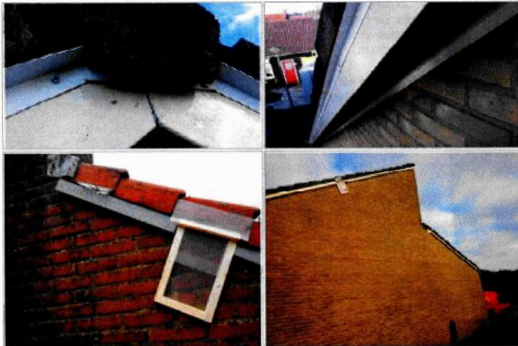
Figuur 13.2. Voorbeelden van hoekprofielen en exclusion flaps.
