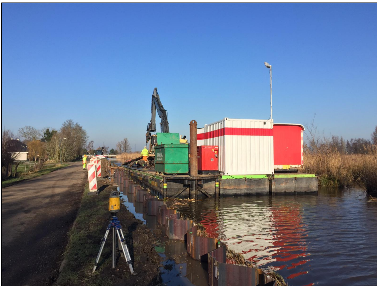
Figuur 4 Een aannemer aan het werk bij een ander project van HDSR.
