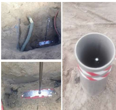
Figuur 7 – zakbaak op leiding t.b.v. monitoring
