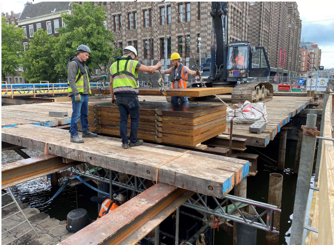
Figuur 4 – plaatsen ballast bij proefbelasting funderingspalen brug 30 Herengracht - Vijzelstraat
