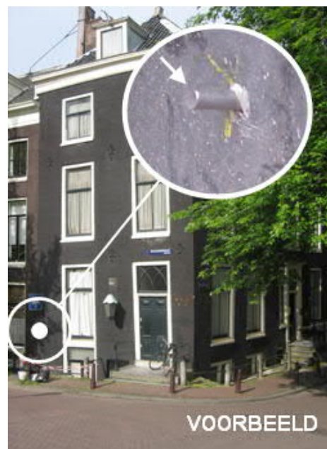
Figuur 6 Voorbeeld hoogtemeetbout
