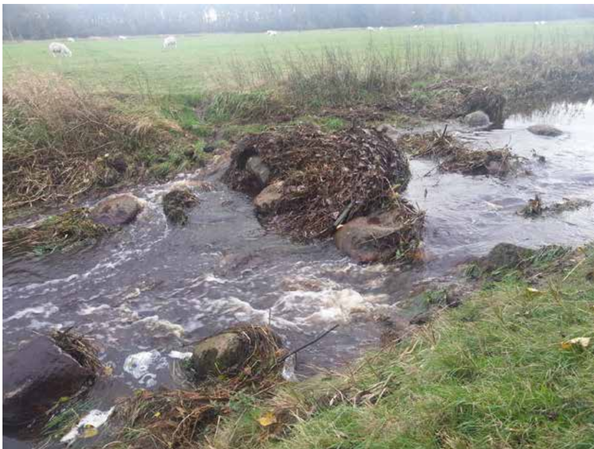
Figuur 1 Vispassage Dwarsdiep met drijfvuil
