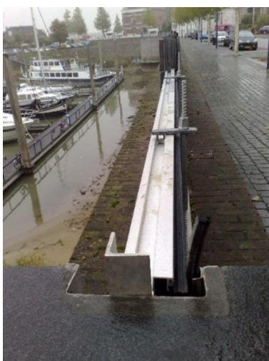
Figuur 6: Voorbeeld flexibele waterkering (bron: https://www.bd.nl/den-bosch-e-o/waterkering-vlot-bedrijfsklaar-a9fbadf4/ )
