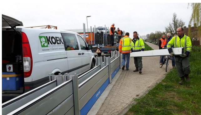
Figuur 4: Tijdelijke waterkering in Werkendam (bron:
