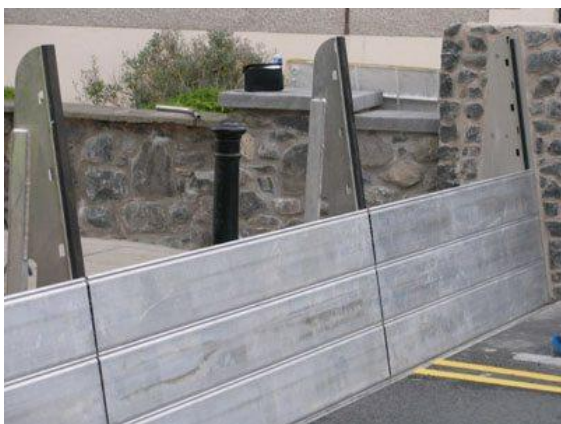
Figuur 5: Tijdelijke waterkering 'Dutchdam' ( bron: https://dutchdam.com/ )
