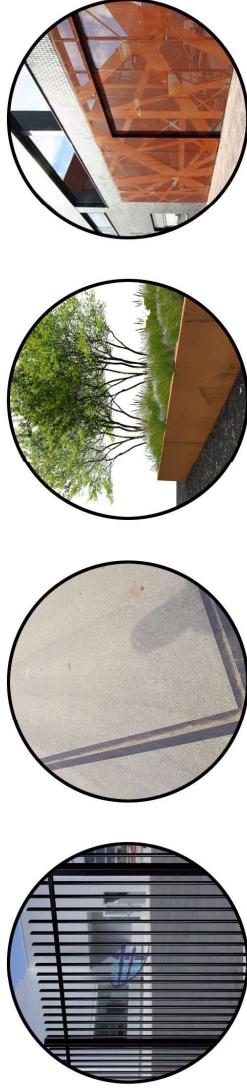
Wereld van de Binnenhavens-De Watersportpier ertafschiedingen en materialisering openbare ruimte: open spijlenhekwerken, semitransparante afscherming buitenopslag, grasbetontegels en betonplaten.
