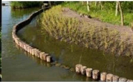
Soort beschoeiing: palenrijbeschoeiing functie: behoud doorstroomprofiel
