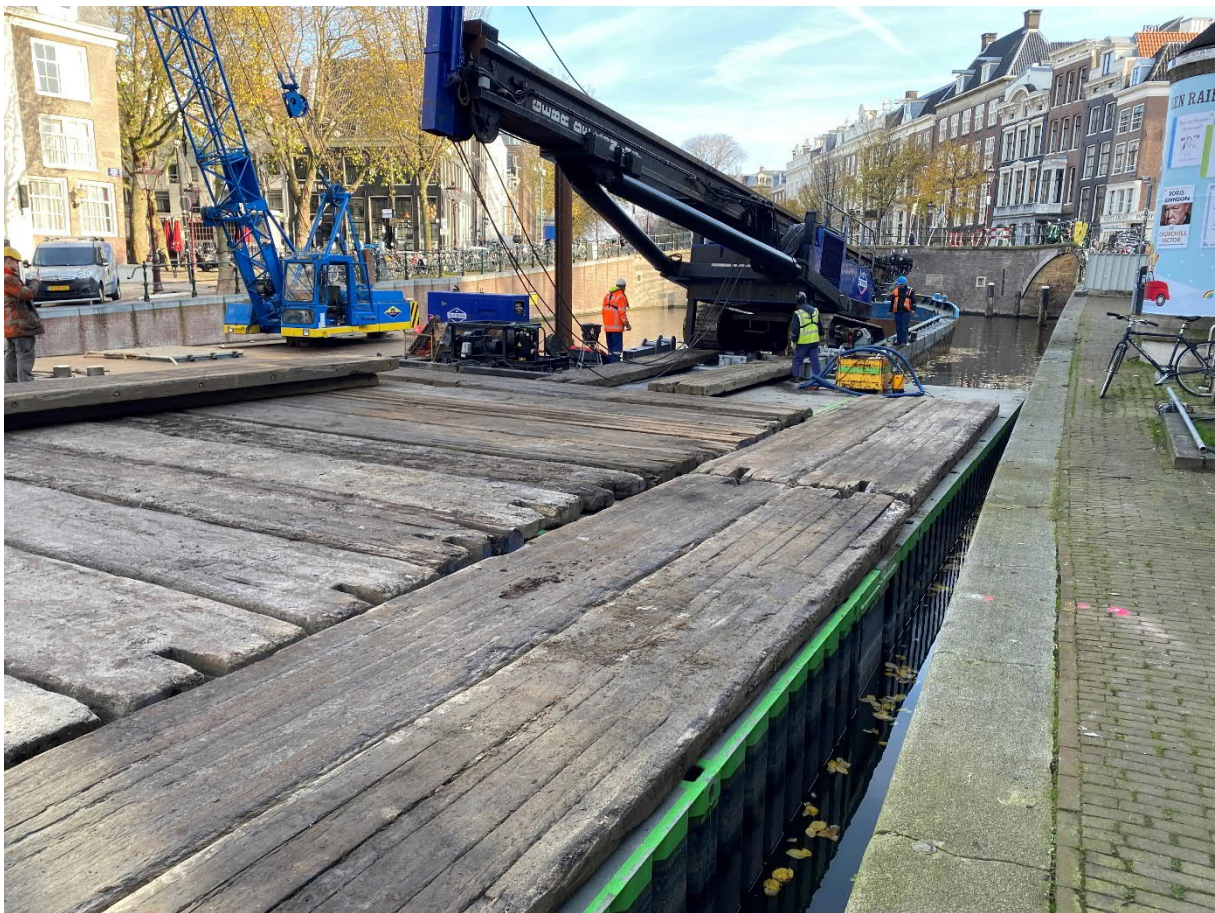
Figuur 2 Aanvoer (met PK11) kraan en opstellen
