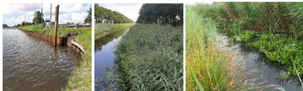
Van links naar rechts: beschoeide oever, rietoever, slenk met vooroever.
