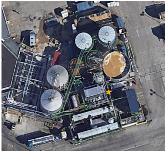
Locatie nieuwe pomp bij zuivering
