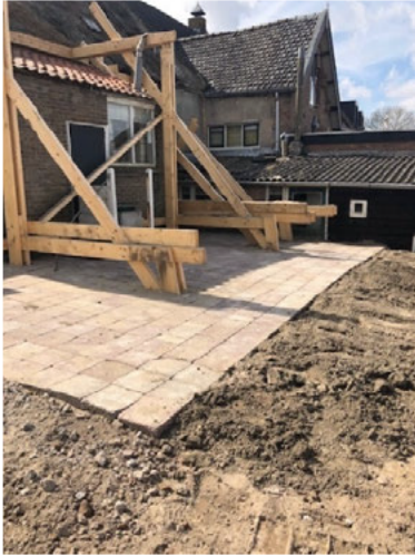
Verharding achterzijde woning
