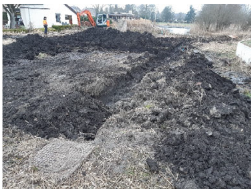
Proefsleuf lokaliseren drukleiding
