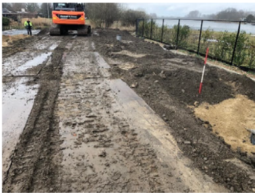
Aanbrengen leeflaag achterterrein
