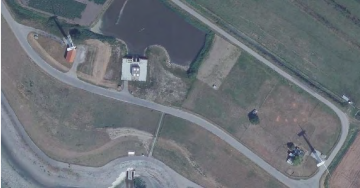
Afbeelding 5.6 Locatie gemaal Schore
