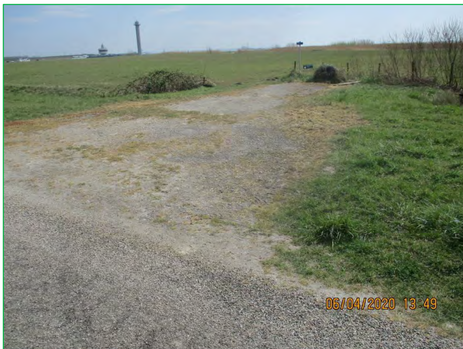
Foto 4. De westelijke dam naar het slibdepot.
