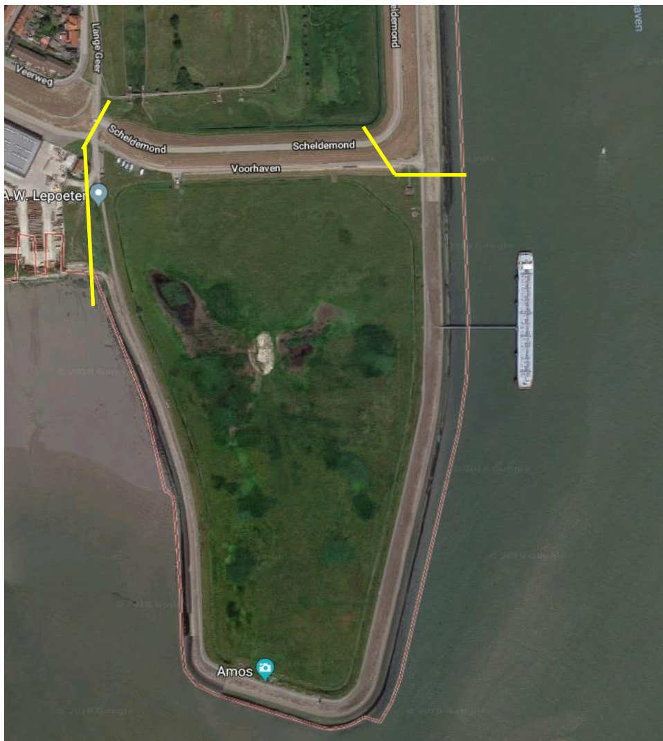
Afbeelding 2.4 Luchtfoto huidige situatie dijksectie Slibdepot ( www.google.com/maps ) (dijksectie tussen gele markeringen)
