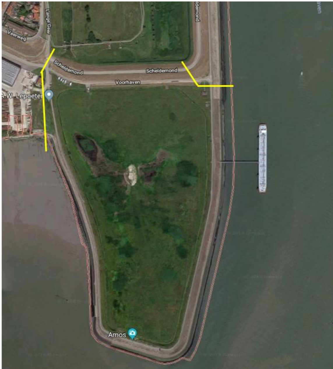
Afbeelding 2.4 Luchtfoto Slibdepot, dijksectie tussen gele markeringen ( www.google.com/maps )
