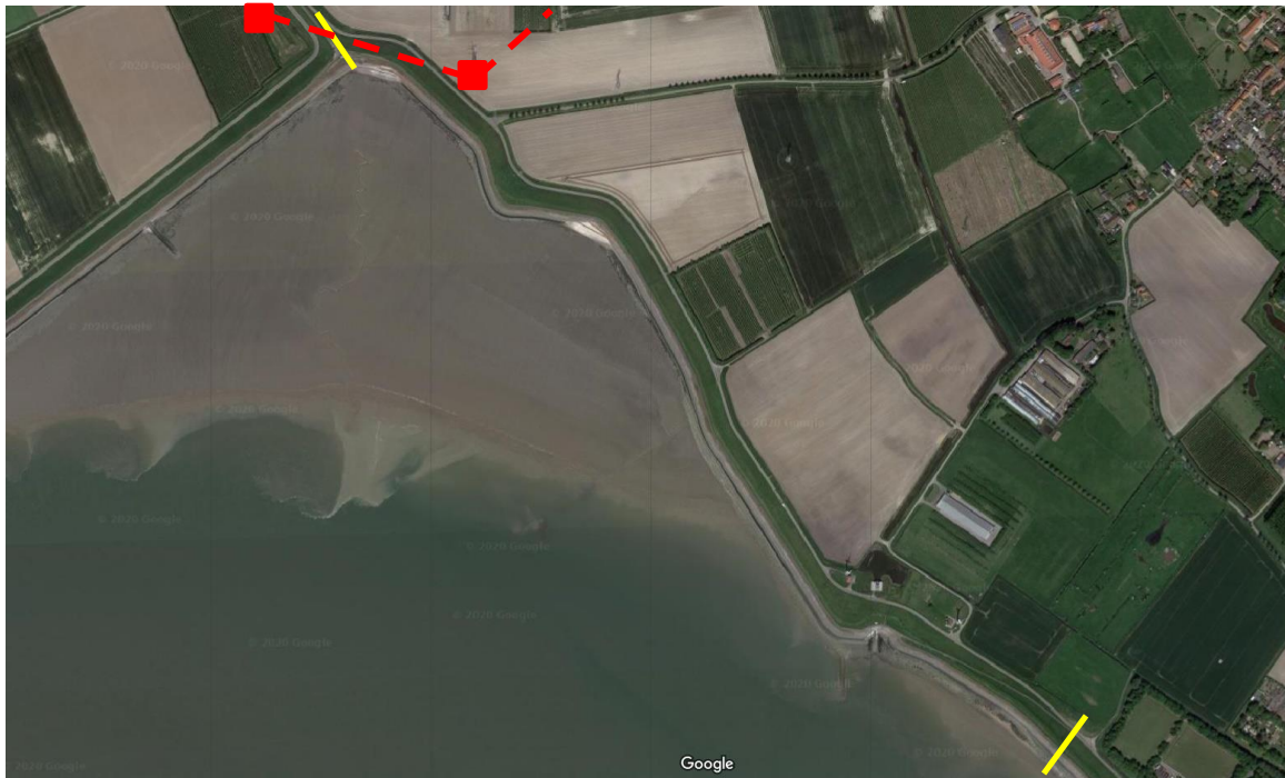
Afbeelding 2.6 Luchtfoto huidige situatie Landelijk gebied en het hoogspanningsnet (rood) (www.google.com)
