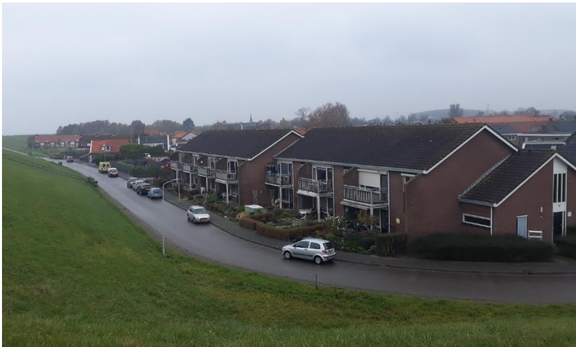
Afbeelding 6.44 Woningen Veerweg (woningen Maasstraat/Zeedijk zichtbaar in de verte)
