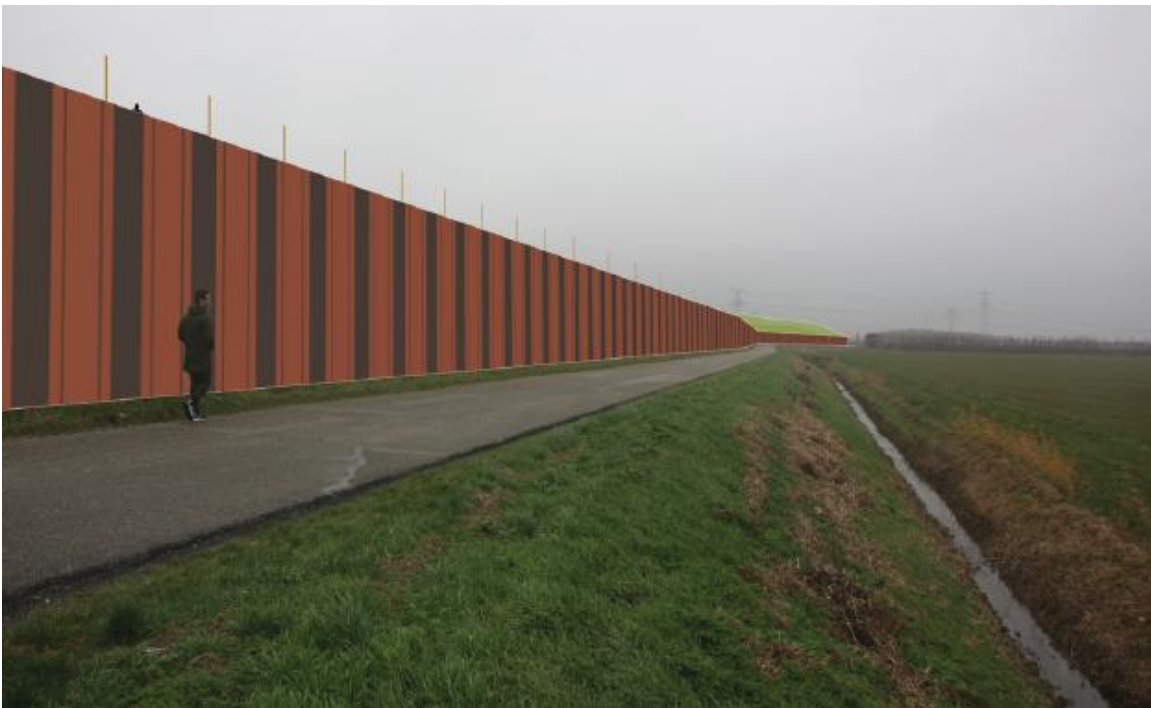
Afbeelding 7.4 Damwand 5 m hoogte in Landelijk gebied (bron: RKK)
