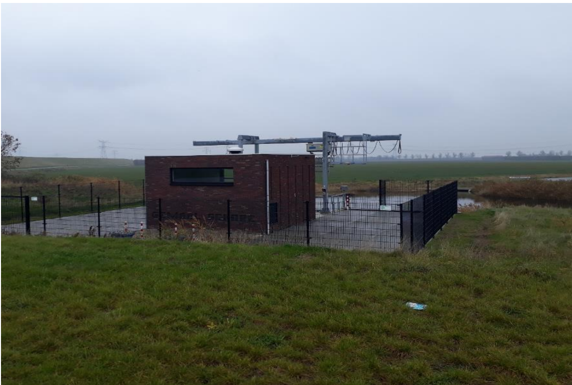
Afbeelding 6.50 Foto gemaal Schore
