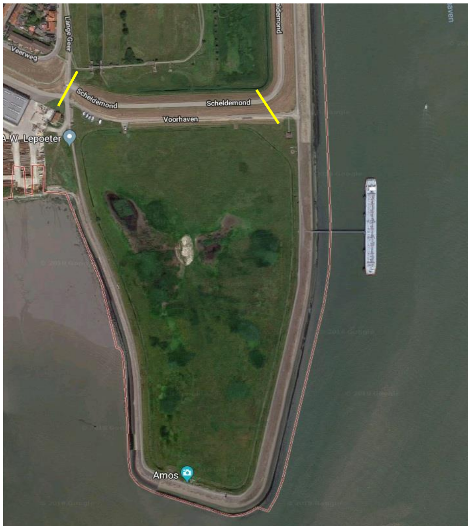
Afbeelding 2.5 Luchtfoto deelgebied Slibdepot (www.google.com) (deelgebied tussen gele markeringen)
