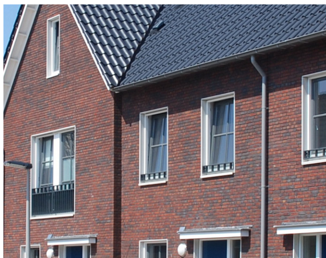
Detailtering ramen. Kenmerkende verticaliteit. Variatie in borstwering, neggemaat en kozijnaanzicht.
