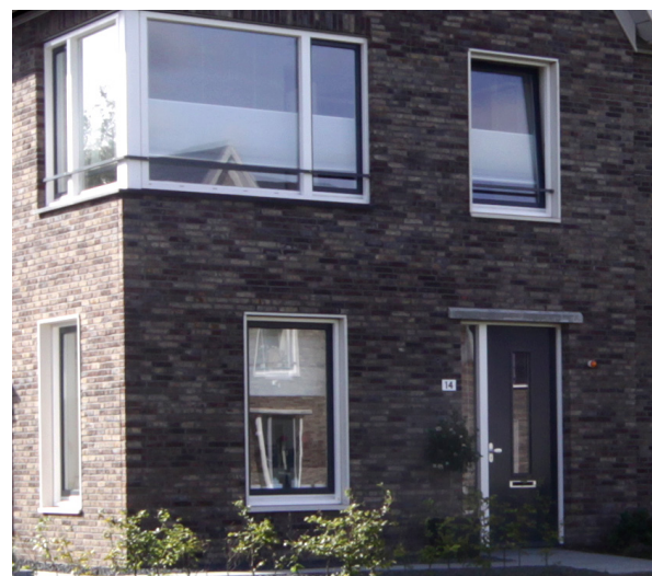
Detailtering ramen. Kenmerkende verticaliteit. Variatie in borstwering, neggemaat en kozijnaanzicht.
