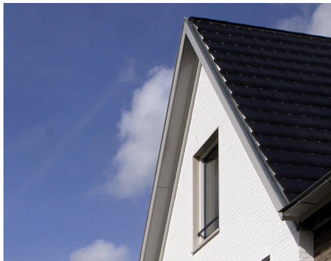
Detailtering overstek. Minimaal 30cm (excl. goot).
